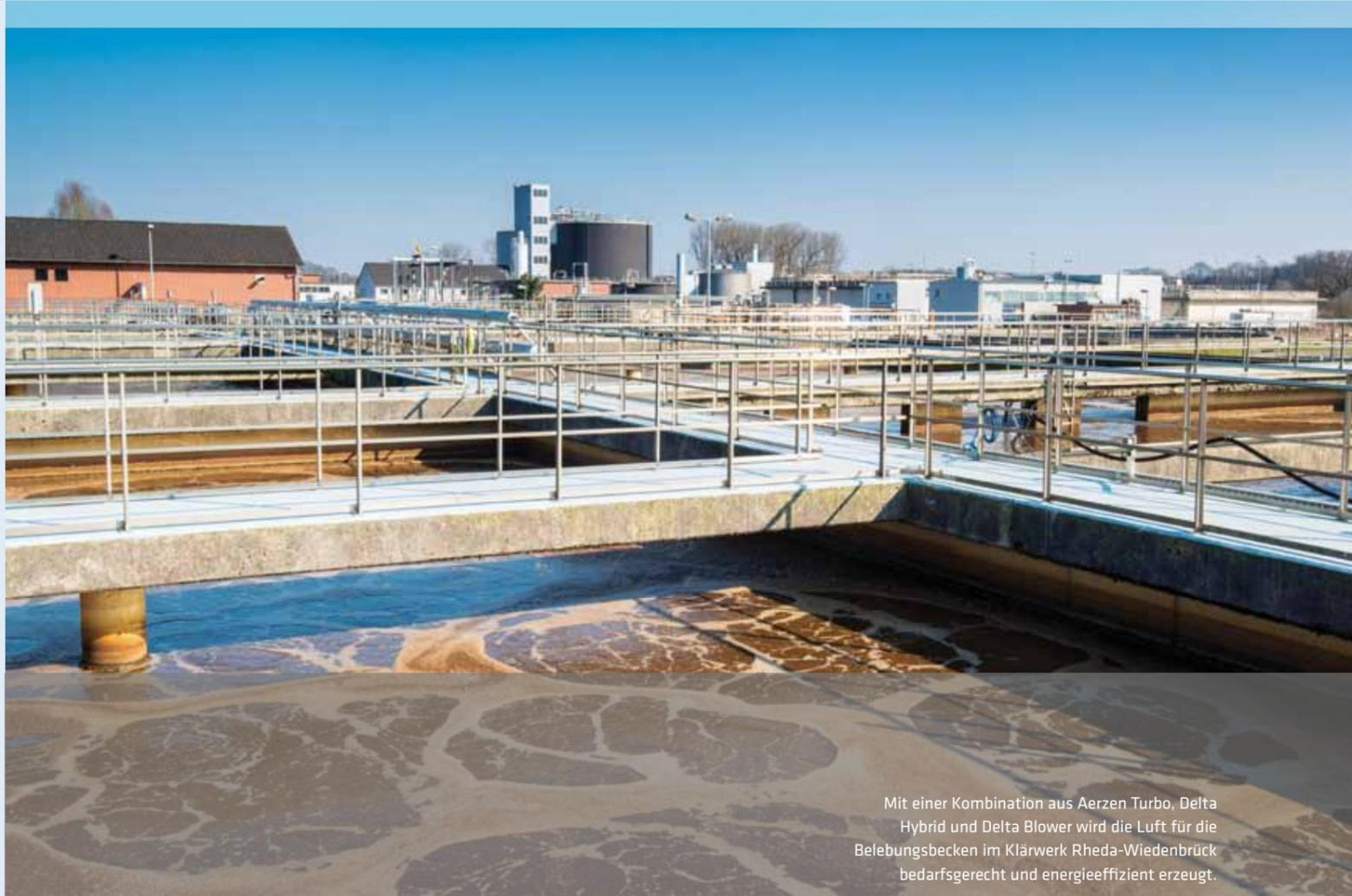
Mit einer Kombination aus Aerzen Turbo, Delta Hybrid und Delta Blower wird die Luft für die Belebungsbecken im Klärwerk Rheda-Wiedenbrück bedarfsgerecht und energieeffizient erzeugt.
